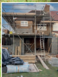
Baustelleneinrichtung nicht im Garten
