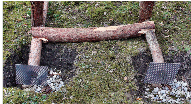
Lochplatten am Steher-Ende verhindern das Einsinken
